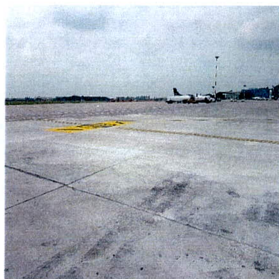
Sursa: CNAB SA (Platforma 1 după reparații curente)
