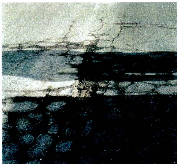
Sursa: CNAB SA (Delta înainte de reparații curente)
