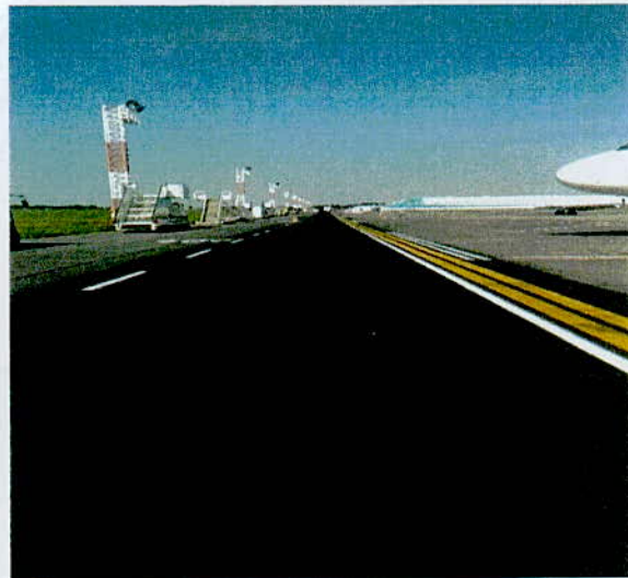
Sursa: CNAB SA (Platforma 2 după reparații curente)
